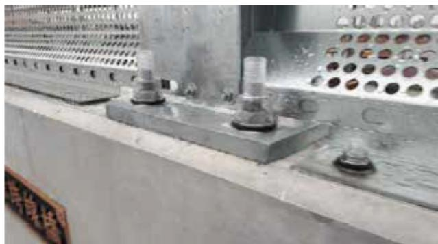
④ボルトナット防錆キャップ装着後
