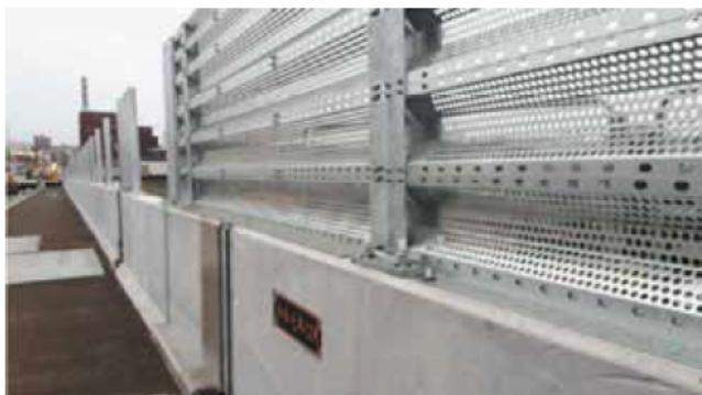
②有孔パネル（高耐食プレめっき鋼板）設置
