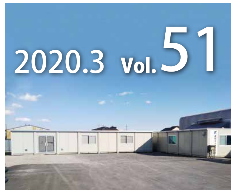
栃木事業所 新棟完成
