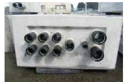
4 エポキシ樹脂硬化後 (表側)
