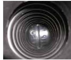
管内部状況(漏水なし)
