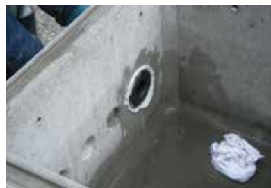
3 エポキシ樹脂にて取り付け (裏側)
