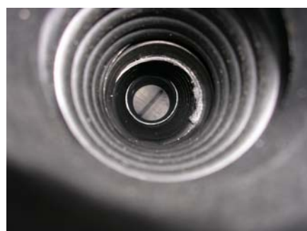
管内止水状況
