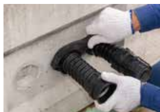
5 ブッシング締め付け 最後までしっかりと締め込む
