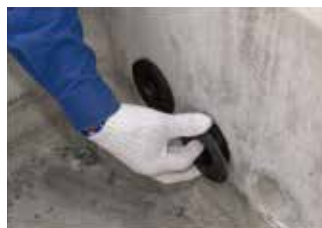
3 接続部にベルマウス取付 最後までしっかりと締め込む
