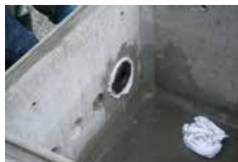
3 エポキシ樹脂にて取付 (裏側)
