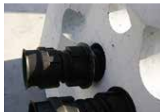
2 接続部に 受け継手を挿入
