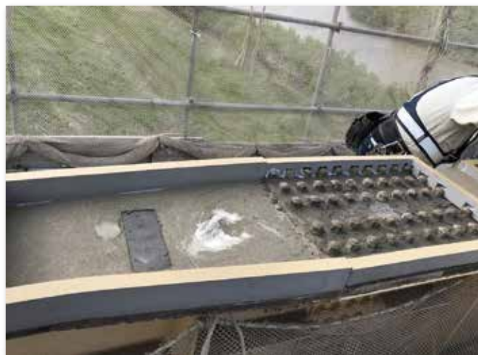
添接(ボルト)接手部
