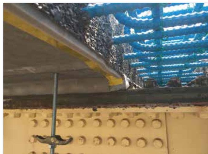
下面 主桁添接部
