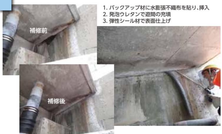
1. バックアップ材に水膨張不織布を貼り、挿入
